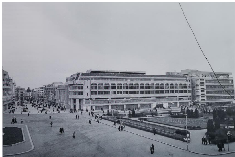
Fig. 2. Extinderea magazinului Mercur, 1982. Sursa: arhiva personală a autorului.
